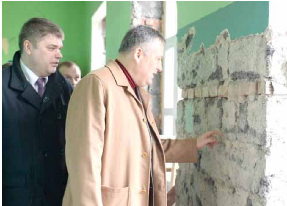
Александр Дрозденко проинспектировал ход ремонтных работ в Доме культуры Кировска. ▲
